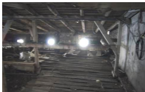
Bēniņu stāva telpas
