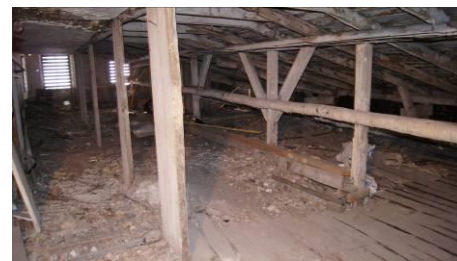
Bēniņu stāva telpas
