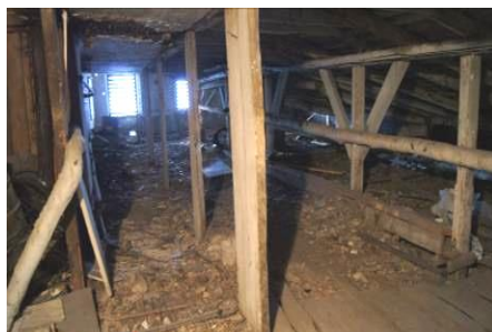
Bēniņu stāva telpas
