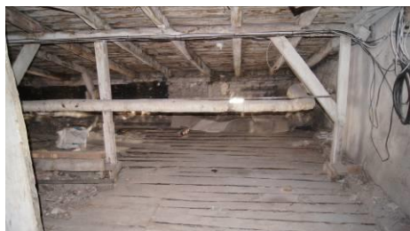
Bēniņu stāva telpas
