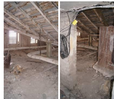
Bēniņu stāva telpas
