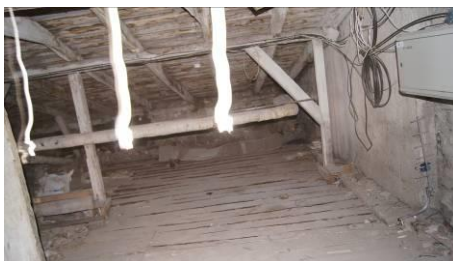
Bēniņu stāva telpas
